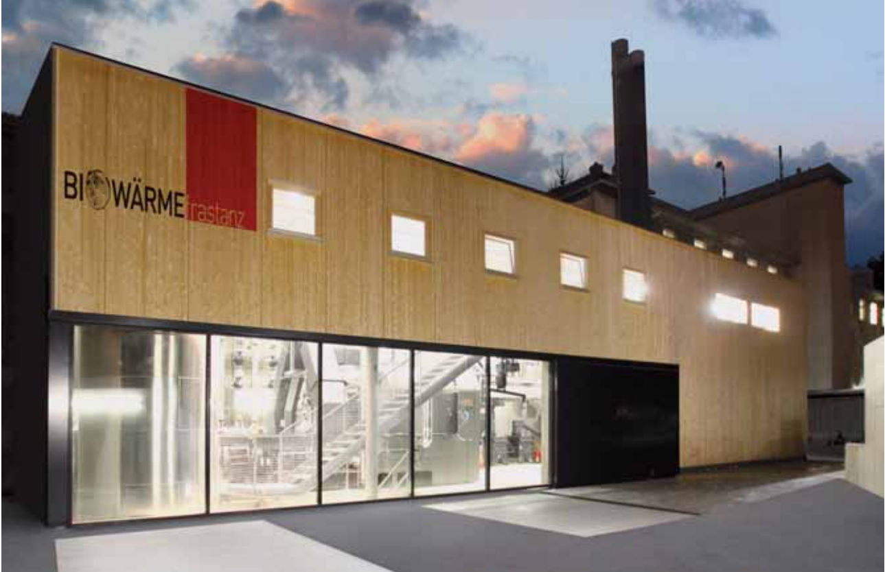
Biowärmezentrale der E-Werke Frastanz, Österreich
